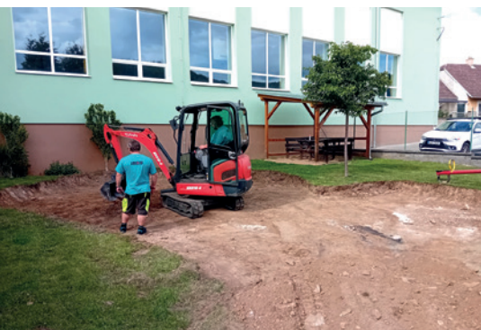
Přípravné práce pro realizaci hřiště.
