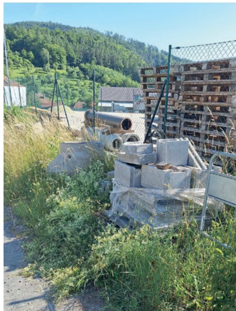
Nevhodné uložení stavebních zbytků na veřejném prostranství, takto uložený materiál neumožňuje údržbu plochy.
