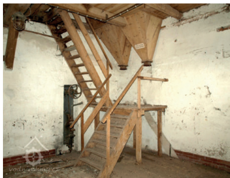
Interiér mlýna – schodiště v roce 2016
