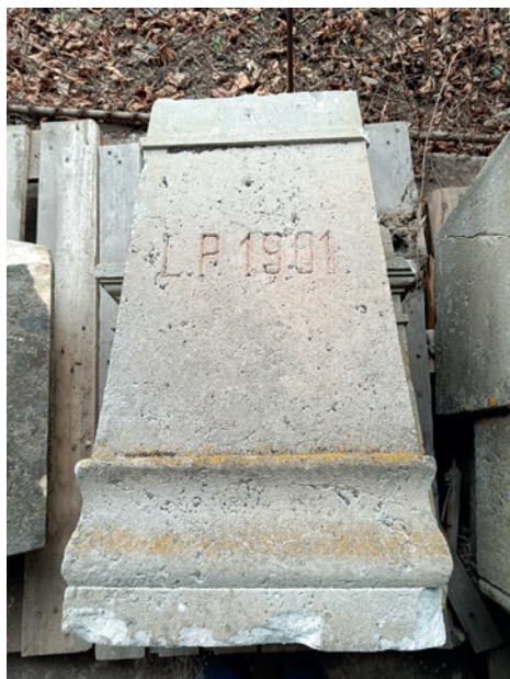
Fragmenty poškozeného křížku poblíž bývalé haly ZZN. Foto: Jana Hladká
