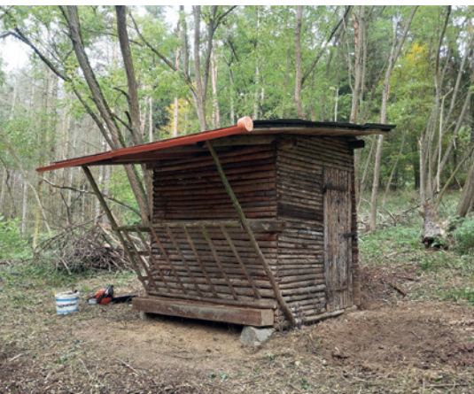
Krmelec po vyčištění a opravě po zimě.
